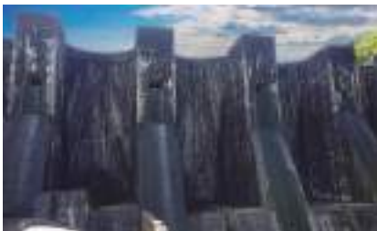
豊稔池堰堤 マルチプルアーチ式 コンクリート造堰堤：観音寺市大野原町
